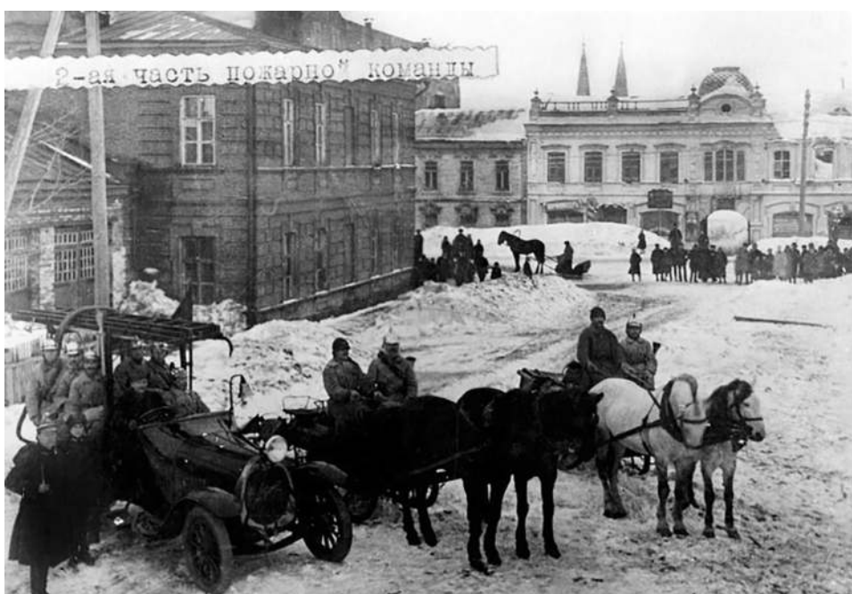
Пожарные 2-й части в Электрическом переулке на фоне домов Давыдова. Около 1927 г.
