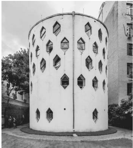
Собственный дом К.С. Мельникова в Кривоарбатском переулке
